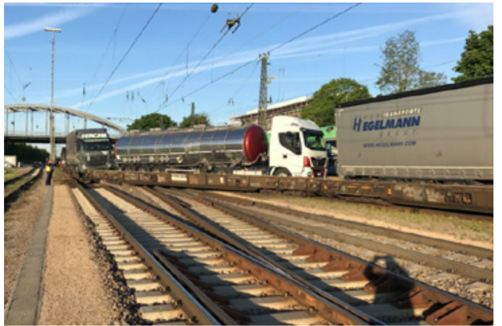
Oben: Kleine Ursache mit grosser Wirkung; entgleister Rola-Zug am 27. April 2018. Unten: Grosser Sachschaden an der Infrastruktur
